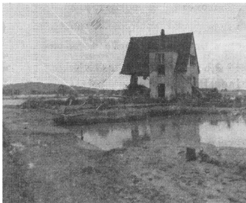
Unterspülte Gleisanlagen und zerstörtes Wohnhaus Niedenführ
