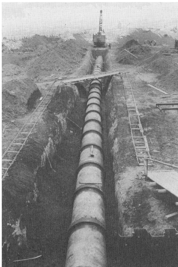
Verlegung einer Rohrleitung, Rohre 120 cm Durchmesser (Foto vom 23. 5. 1940)
