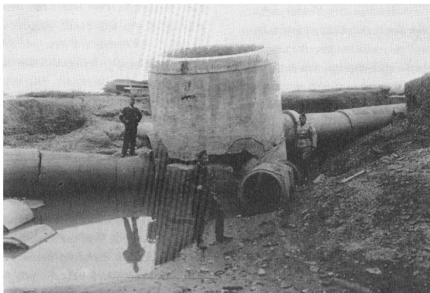
Durch die Möhnekatastrophe zerstörter Schieberschacht (Foto vom 2. 7. 1943)
